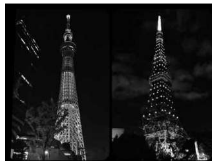
パープル・ライトアップ (東京スカイツリー・東京タワー)
