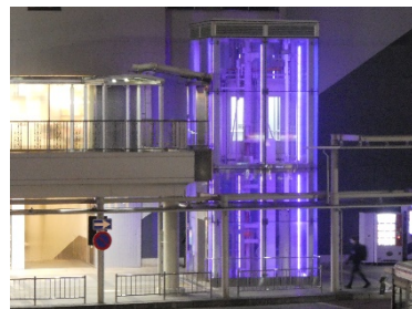
土浦駅西口シースルー エレベーター (茨城県)
