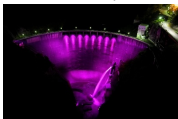
鳴子ダム (宮城県)
