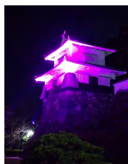
大村公園板敷橋 (長崎県)
