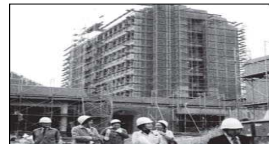
(建設中のNVEC 1976年11月)
