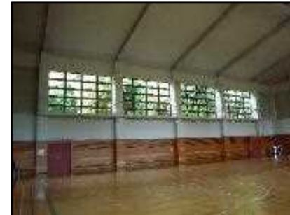
体育館排煙窓故障修繕
