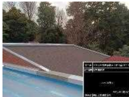
屋上防水改修（浴室棟）
