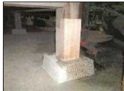
響書院隅柱修繕
