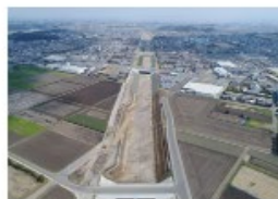
(平成30年3月完成)南城市改良工事
