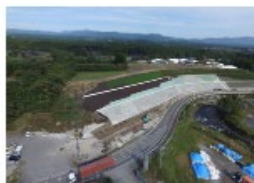
(平成29年11月完成)種子田法面工事小
