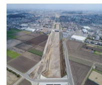
（平成30年3月完成）南橋市改良工事
