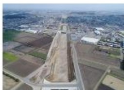
(平成30年3月完成)南城市改良工事
