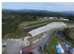
(平成29年11月完成)種子田法面工事①
