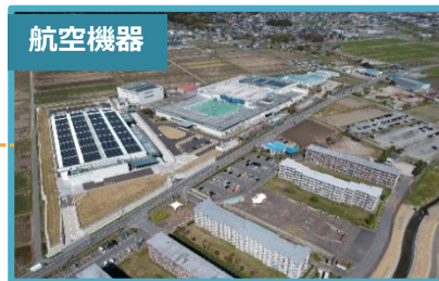
岐阜工場（岐阜県垂井町）
