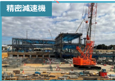
浜松工場（建設中 静岡県浜松市）
