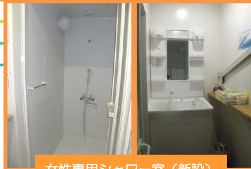
女性専用シャワー室（新設）
