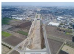
(平成30年3月完成)南州市改良工事
