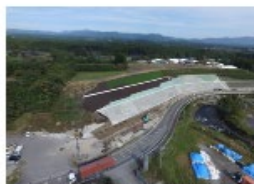
(平成29年11月完成)種子田法面工事小
