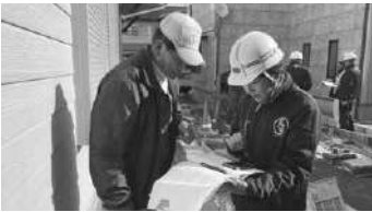
工事現場で職人さんに確認をする女性社員
