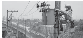
電柱に昇って点検をする女性従業員
