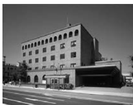
石川県女性センター外観
