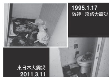
図3 震災当日の避難所のトイレ
