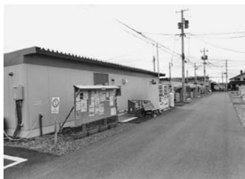
仮設住宅集会所の外観
