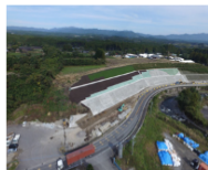
（平成29年11月完成）理子田沼工事①
