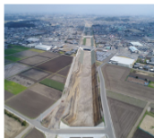
（平成30年3月完成）南瀬河改良工事
