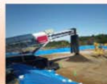
中間貯蔵施設 土壌貯蔵
